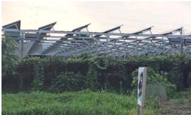
営農型太陽光パネル(山梨県甲府市) ブドウ棚の上に太陽光パネルが設定されている
