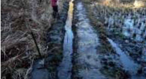
泥上げをして水路がきれいになりました
