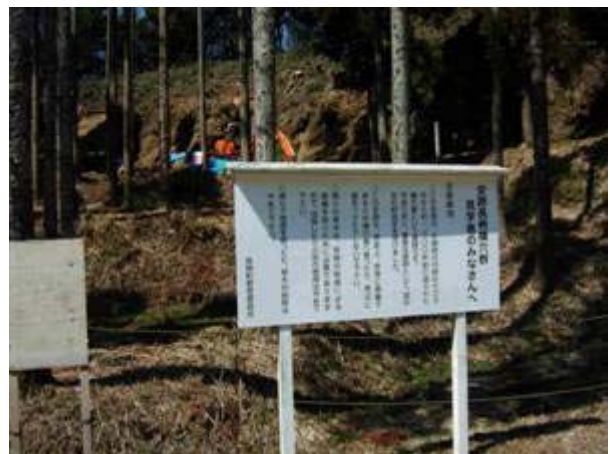
図6. 史跡の整備工事
