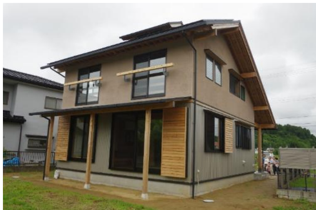
屋根にソーラーパネルを設置した中村邸(2014年6月28日)
